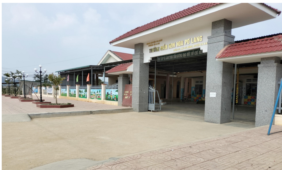
Hình ảnh cổng trường, tường rào và vỉa hè điểm chính sau khi tu sửa
